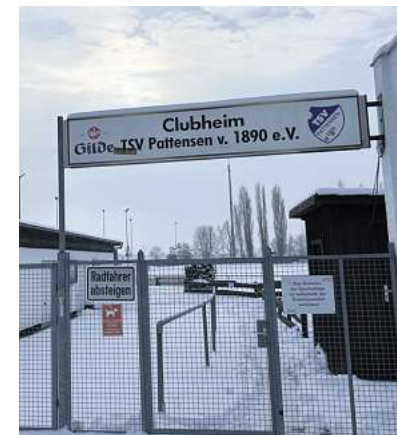
Probleme mit Feuchtigkeit in der Wand: Der TSV Pattensen plant eine energetische Sanierung.
